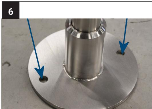
Stellen Sie die Pfosten mittig auf die eingezeichneten Pfostenmarkierungen. Achten Sie darauf, dass die Glashalter in gerader Flucht zum nächsten Pfosten ausgerichtet sind.
