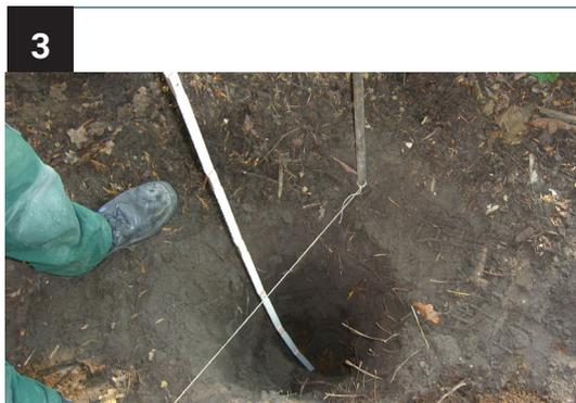
Setzen Sie den Pfosten in die ausgehobenen Erdlöcher. Messen Sie die Tiefe entsprechend der bestellten Pfostenlänge aus. In der Regel werden unsere Pfosten 500 mm länger als die Windschutzhöhe gefertigt.
