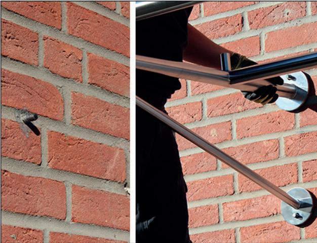
Aufsetzen des Rohrahmens auf die herausstehenden Gewindestangen
