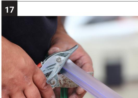
Kürzen Sie die Dichtung mit Hilfe einer Gehrungsschere.
