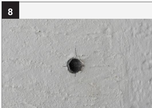
Schieben Sie die Siebhülsen in die Bohrlöcher. Sie müssen bündig mit der Wand abschließen.
