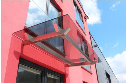
Beispielanwendung: Skala mit Längst- und Querträgern
