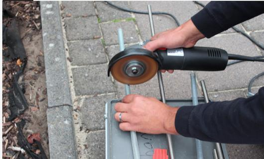
Sofern Sie aufgrund Ihres Maueruntergrundes Siebhülsen einsetzen, schneiden Sie diese auf Bohrlochtiefe.
