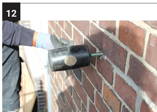
Klopfen Sie die Gewindestangen mit einem Gummihammer bis zum Anschlag ein.
