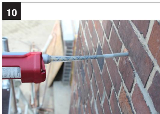
Führen Sie die Silikonkanüle in das Bohrloch und drücken den Kleber gleichmäßig aus der Kartusche. Ziehen Sie die Silikonkanüle dabei langsam aus dem Bohrloch.
