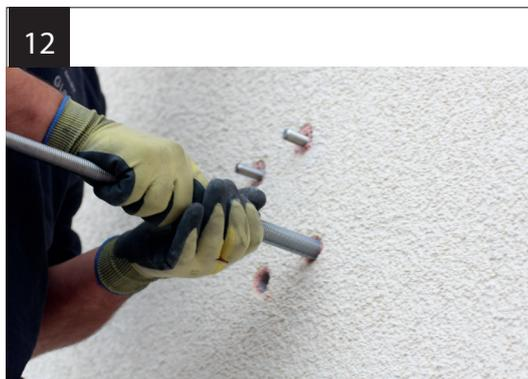
Schieben Sie die Siebhülsen in die Bohrlöcher.
