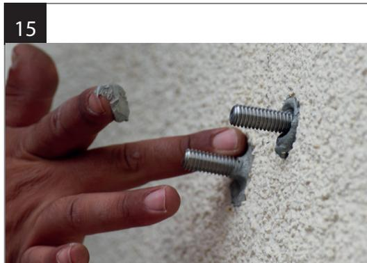
Entfernen Sie überflüssige Kleberreste mit der Hand oder einem Papiertuch.
