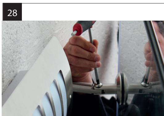
Verschrauben Sie das Verbindungsgelenk mit dem Glashalter.
