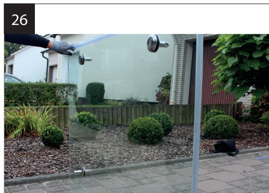
Die Glashalter-Stege für die Zugstreben-Befestigung sind zur Oberseite ausgerichtet und die Glashalter-Stege für die Wand-Glashalter zeigen zur Unterseite.
