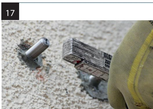
Überprüfen Sie während der Aushärtezeit noch einmal die Abstände der Gewindestangen und richten Sie ggfs. die Stangen passend aus.
