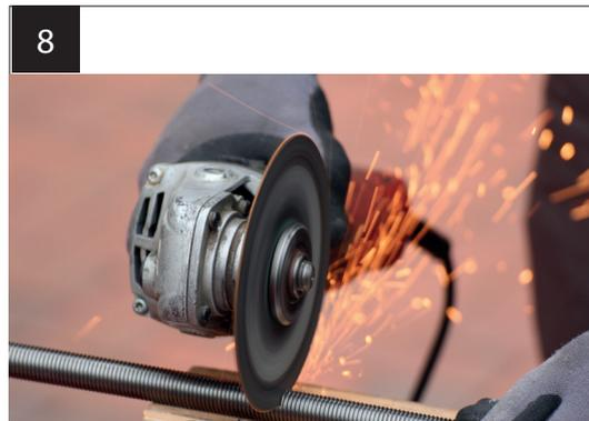
Schneiden Sie die Gewindestangen auf die benötigte Länge zu.
