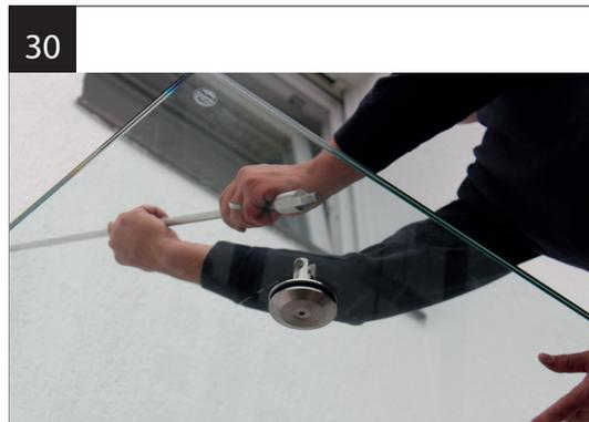
Klappen Sie das Glas hoch, bis Sie mit den vorderen Glashaltern die Zugstäbe erreichen. Schrauben Sie die Gelenke der Zugstäbe mit dem Inbusschlüssel an die vorderen Glashalter.
