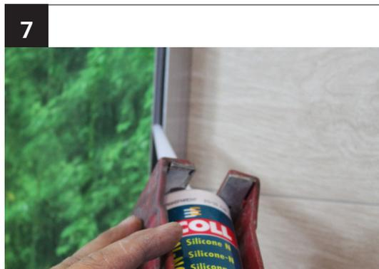
Ziehen Sie gleichmäßig eine Klebeschicht auf die U-Profile an der Wand und dem Boden mit der Silikonpistole ein.
