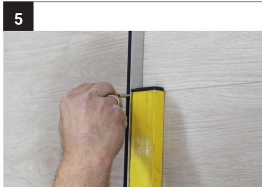
Zeichnen Sie mit Hilfe der Wasserwaage die Bohrlöcher an.
