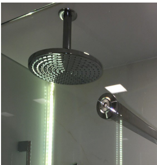
verschraubte Stabstange im Glas
