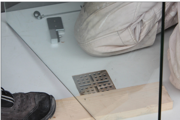
Beispielanwendung: Glas steht auf Holz.
