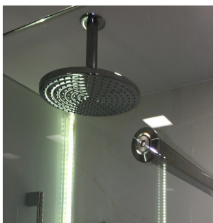
verschraubte Stabstange im Glas
