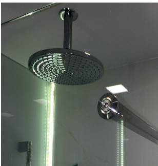
verschraubte Stabstange im Glas
