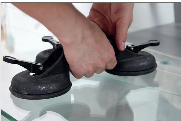
Einsatz eines Glassaugers
