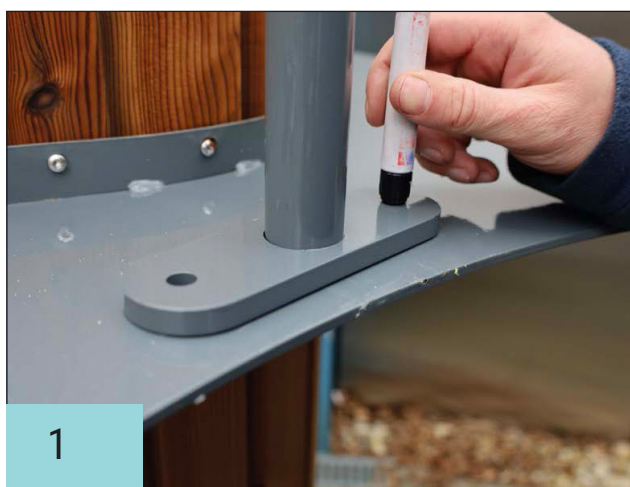
Lochbohrungen markieren
