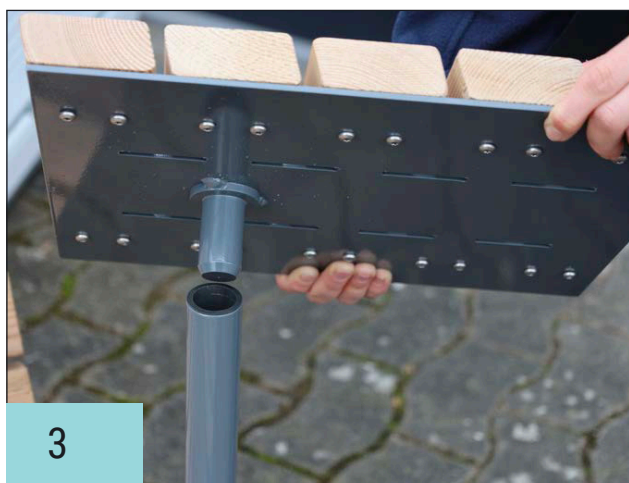
Tischplatte auf Rohr stecken
