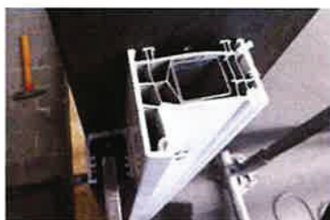
Bild 2.3 Blendrahmen aus Kunststoff mit Einschiebling aus Stahl t \geq 1,5 mm Exemplarische Anordnung Steifigkeitswerte Einschiebling
