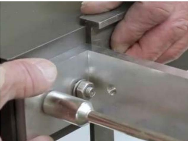
2. Montage und Ausrichten des Befestigungswinkels am Unterzug.
