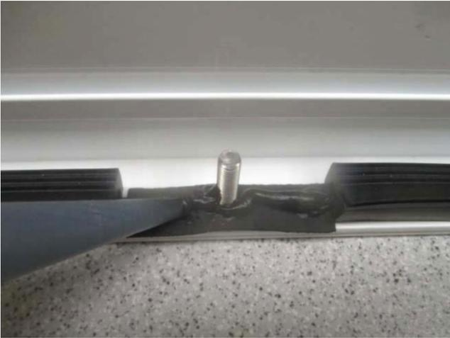
1. Silikon auf Dichtstück auftragen und Glasstoßunterteil über die Befestigungsschraube legen.
