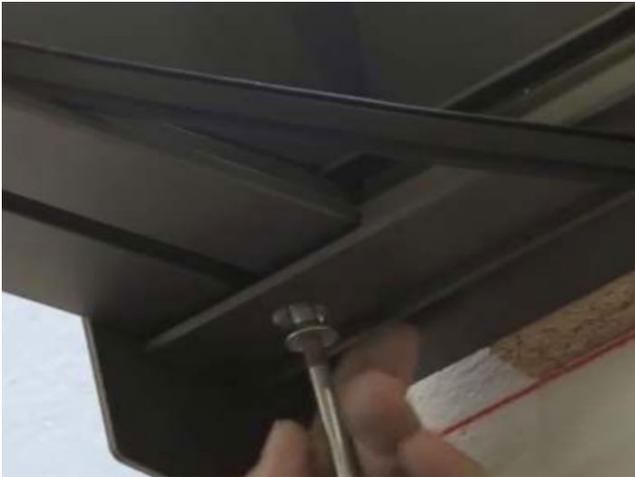
Seitensparren mit Senkkopfschrauben unterhalb der Traverse befestigen.
