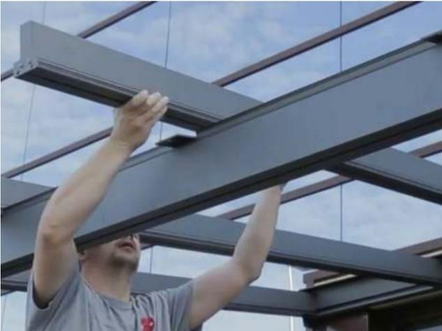
Montage der Mittelsparren (gleiche Abfolge wie bei den Seitensparren).
