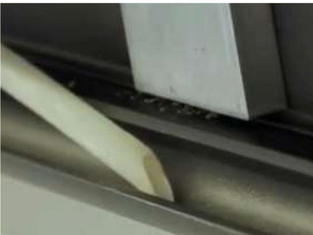
5. Wandanschluss-Profil nach beendeter Befestigung von Bohrstaub und Spänen säubern.
