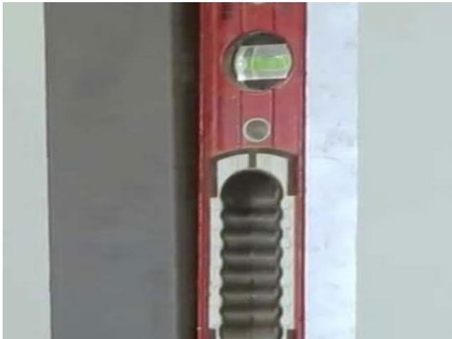
Stützen mit Wasserwaage ausrichten.
