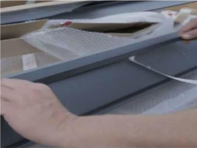
1. Anbringung bauseitiges Kompri-Band an Wandanschluss-Rückseite.
