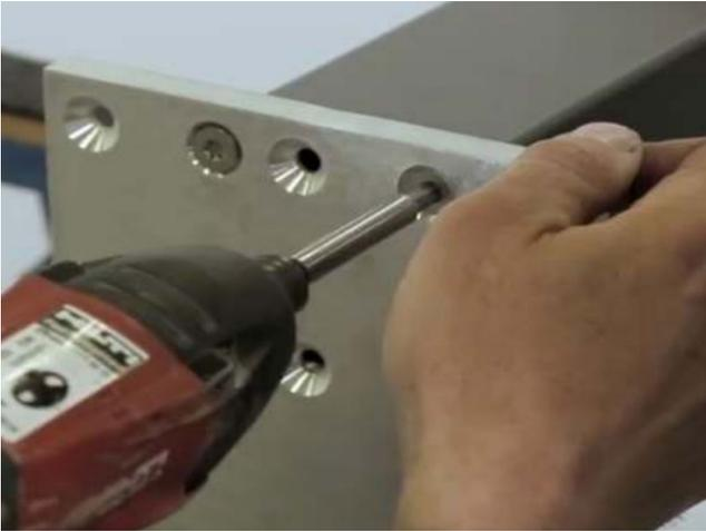
1. Befestigung Fußplatten an Stützenunterseite mit Gewindefurchschraube.
