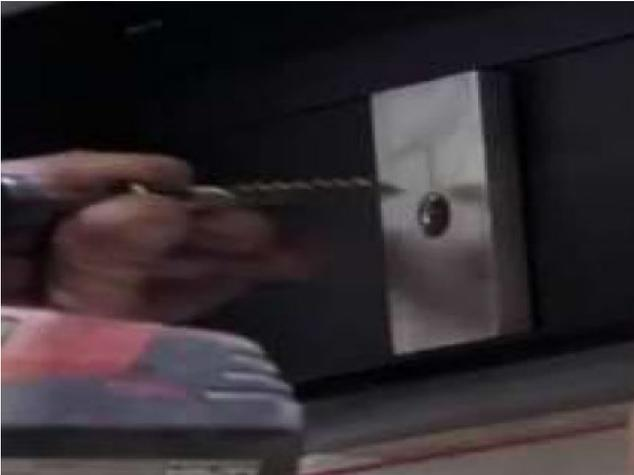
4. Wandanschluss mit Montageplatten befestigen und in Waage legen.
