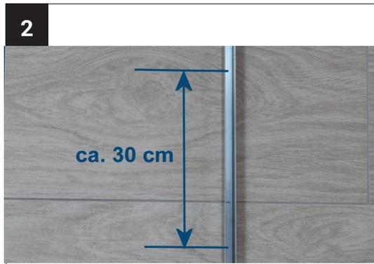
Ermitteln Sie die optimalen Bohrlochabstände, indem Sie ca. alle 30 cm eine Bohrlochmarkierung im Profil einzeichnen. Verschieben Sie die Löcher, die direkt an der Fliesenkante liegen. Achten Sie darauf, dass Sie je ein Bohrloch unten und oben nahe am Profilende einzeichnen.
