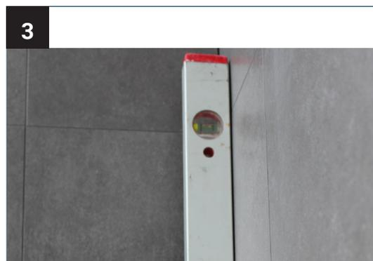
Überprüfen Sie eine eventuelle Lotabweichung mit Hilfe der Wasserwaage.
