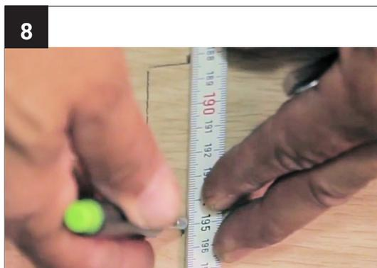
Stellen Sie das Glas nun sicher zur Seite und nehmen das Bandunterteil ab. Legen Sie das Bandunterteil an den Wandmarkierungen an und zeichnen den den gesamten Umriss an.
