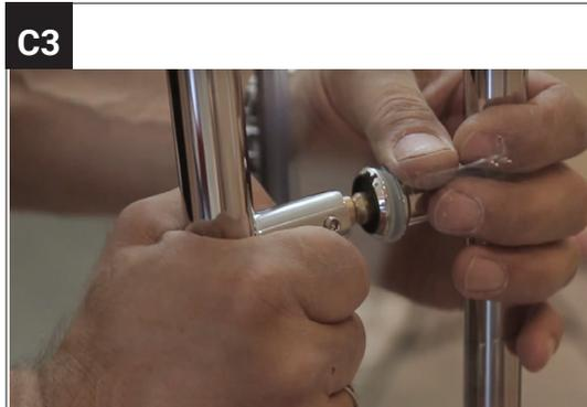
Schieben Sie die andere Hälfte der Griffstange auf die verschraubten Halter. Richten Sie die Stange bündig aus und fixieren Sie diese, indem Sie die Madenschrauben an beiden Seiten fest anziehen.
