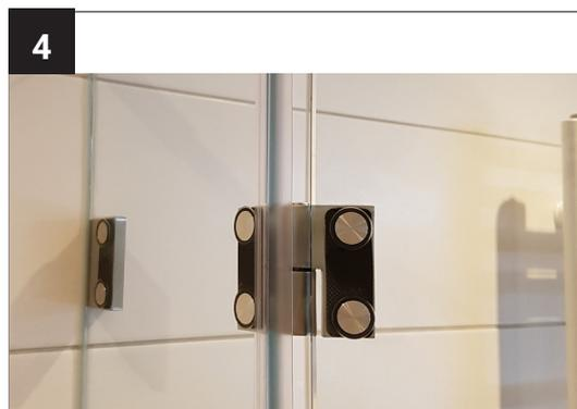
Heben Sie die Glastür mit Hilfe eines Glas-saugers an und setzen sie am oberen und unteren Türband parallel ein.
