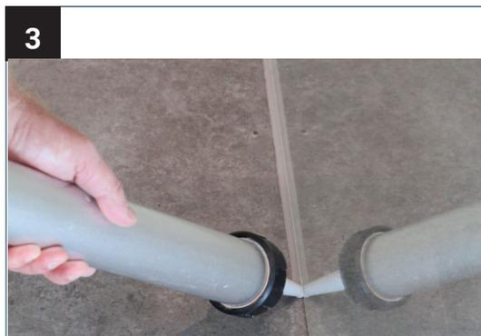
Ziehen Sie die Kartusche in gleichmäßiger Bewegung und gleich bleibendem Druck über den Spalt.
