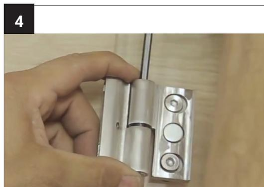
Stecken Sie das untere Türbandteil auf den Dorn. Schrauben Sie das Türband mit Hilfe eines Inbusschlüssels fest.
