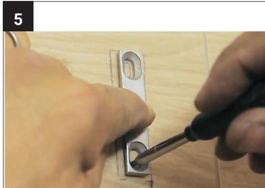
Legen Sie die Schwalbenschwanzplatte auf die Markierung und zeichnen Sie die Bohrlöcher an der Wand an.
