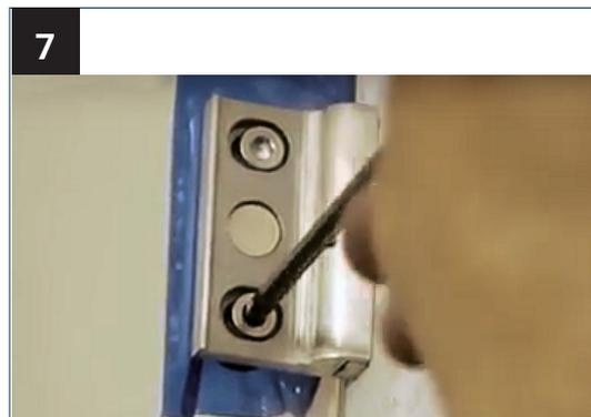
Richten Sie das Glas passend aus und schrauben Sie die Punkthalter im Winkel fest. Entfernen Sie das Klebeband, bevor Sie die Schrauben ganz fest schrauben.
