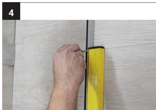
Legen Sie das Profil entlang der Wasserwaage an der Wand an und zeichnen die Bohrlöcher ein.
