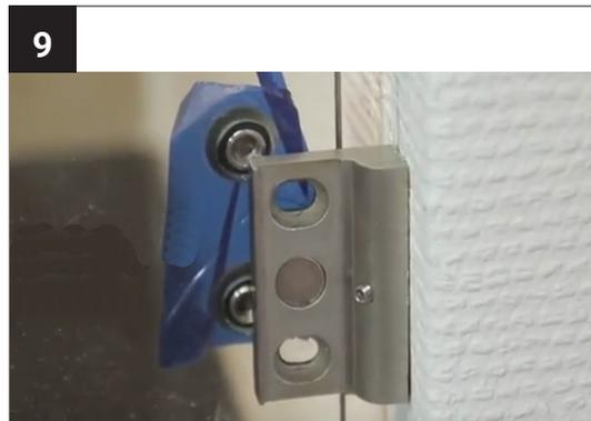
Setzen Sie die Punkthalter ins Glas. Fixieren Sie diese mit einem Klebeband, damit sie nicht raus rutschen.
