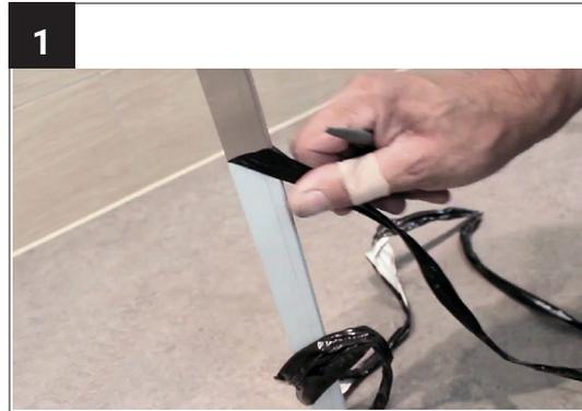
Entfernen Sie zuerst die Schutzfolie am U-Profil.
