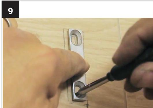
Lösen Sie die Schwalbenschwanzplatte vom Türband, indem Sie die Madenschraube lockern. Legen Sie die Platte auf die Markierung und zeichnen Sie die Bohrlöcher an der Wand an.
