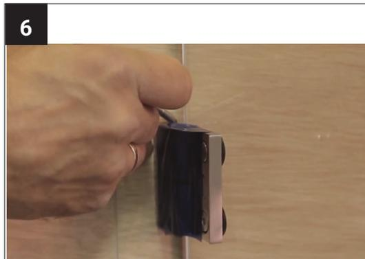
Zeichnen Sie je an der oberen und unteren Kante des Winkels eine Linie an.
