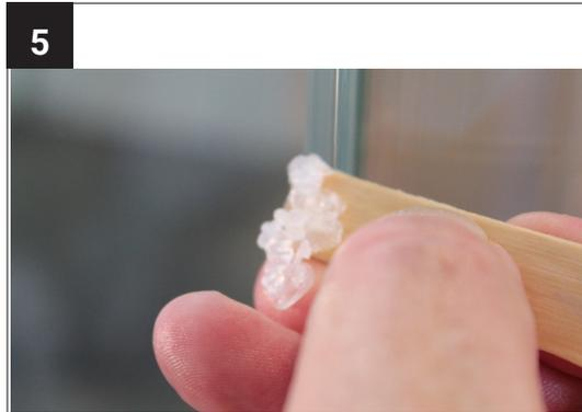
Ziehen Sie die Silikon-Überreste mit einem Eisstiel aus Holz oder einem Silikon-Abzieher ab.
