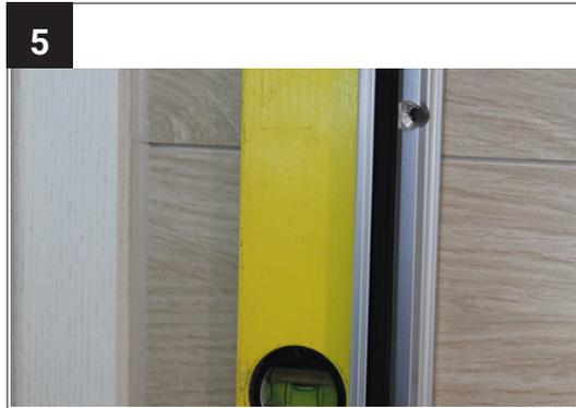
Halten Sie das Profil an der Geraden an und zeichnen die Bohrlöcher mit einem Stift an.
