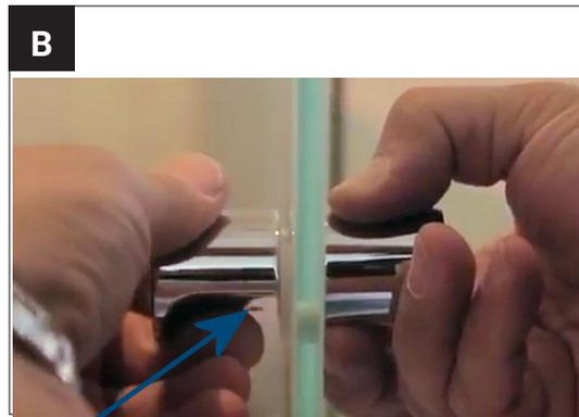
Sofern Sie einen Türgriff mit Mulde einsetzen, achten Sie darauf, dass Sie den Griff so drehen, dass die Mulde nach unten gerichtet ist. Schrauben Sie die Madenschraube dann mit einem Inbusschlüssel fest.
