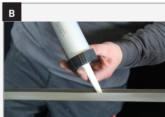
Mit einem hochwertigen Montagekleber lässt sich das U-Profil auch einfach an die Wand kleben, ohne dass Sie bohren müssen.
