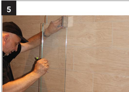
Positionieren Sie das Glas mit den Winkeln an der Wand. Richten Sie das Glas mit Hilfe einer Wasserwaage lotgerecht aus.
