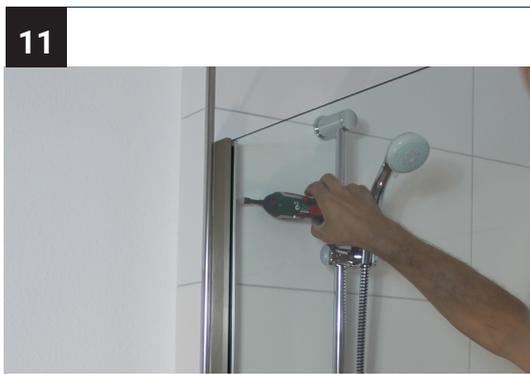
Richten Sie die Glasscheibe bündig aus und schrauben den Adapter fest. Ziehen Sie die Schrauben mit einem Inbusschlüssel nach.
