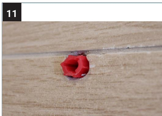
Schieben Sie die Dübel in die Bohrlöcher ein. Überstehende Ränder schneiden Sie mit einer Rasierklinge oder einem Teppichmesser ab.
