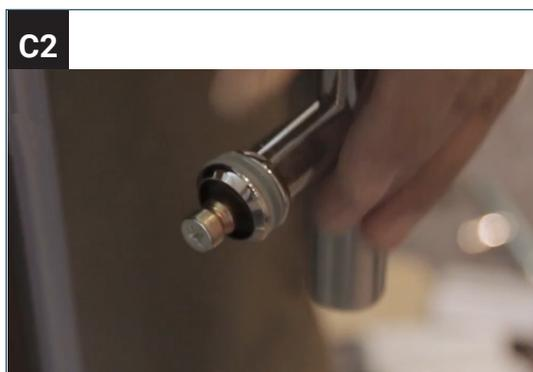
Befestigen Sie nun die untere Glasverschraubung der Griffstange und schrauben den Griff fest an.
