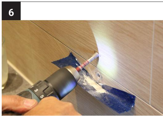
Verwenden Sie den für den Untergrund passenden Bohrer.
