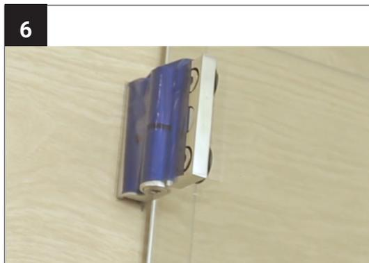
Positionieren Sie das Glas an der Wand. Richten Sie das Glas mit Hilfe einer Wasserwaage lotgerecht aus.
