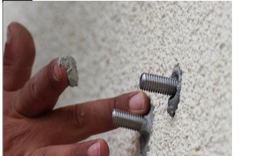
Entfernen Sie überflüssige Kleberreste mit der Hand oder einem Papiertuch.
