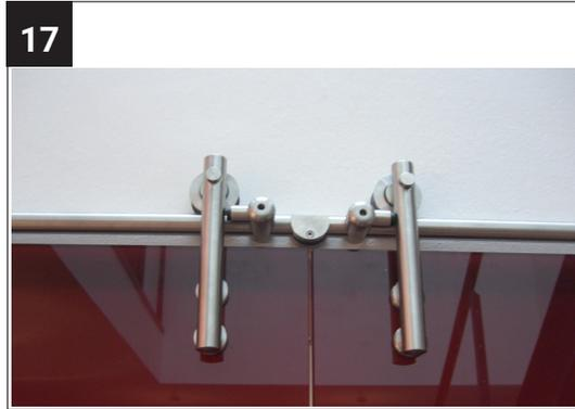
Die Stopper-Position bei einer 2-flügeligen Tür ermitteln Sie im geschlossenen Zustand der Türen. Die Fixierung der Stopper erfolgt wie in Schritt 16 beschrieben.
