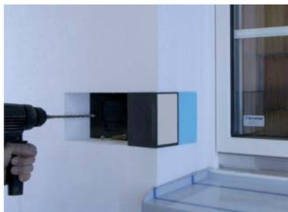
Mechanische Befestigung erst nach dem Aushärten des Klebemörtels vornehmen. Die Eignung der mitgelieferten Schraubdübel muss für den vorliegenden Untergrund überprüft werden. Falls diese nicht geeignet sind, müssen sie auf Kosten des Bestellers ausgewechselt werden.
