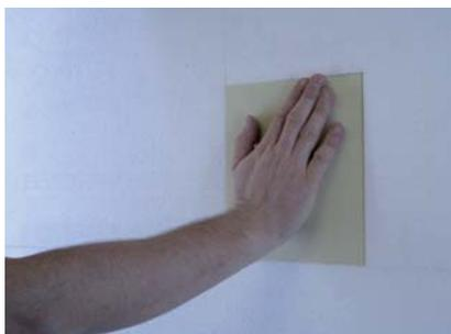
StoFix Quader Maxi dämmplattenbündig anpressen.
