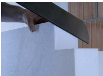
Es empfiehlt sich, die StoFix Quader Mini/Midi gleichzeitig mit dem Kleben der Dämmplatten zu versetzen.
