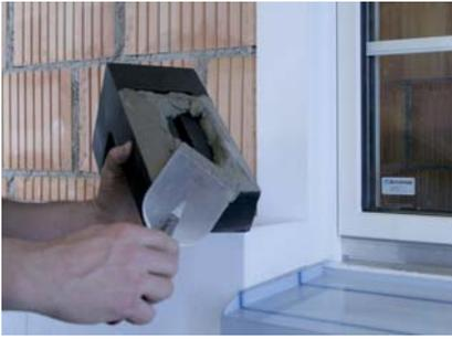
Es empfiehlt sich, das StoFix TraWik F gleichzeitig mit dem Kleben der Dämmplatten zu versetzen.
