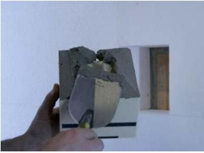
EPS-Stopfen aus der Nische herausnehmen und auf die innere Klebefläche der StoFix UMP-Q Klebemörtel aufziehen. Element muss vollflächig verklebt werden.
