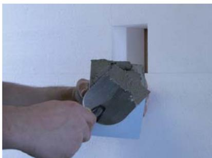
Auf die innere Klebefläche des StoFix Quader Mini/Midi Klebemörtel aufziehen.
