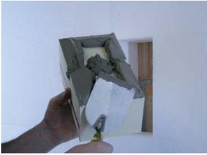
EPS-Stopfen aus der Nische herausnehmen und auf die innere Klebefläche der StoFix UMP-R Klebemörtel aufziehen.
