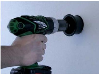
Mit Fräswerkzeug für StoFix Zyrillo Ausfräsung in Dämmplatte fräsen und vom Frässtaub reinigen.
