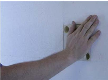
StoFix UMP-Q dämmplattenbündig anpressen.
