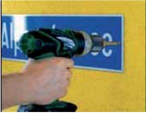
Bauteil in die StoFix Spirale mit 4 - 5 mm Blech-/Holzschraube verschrauben.
