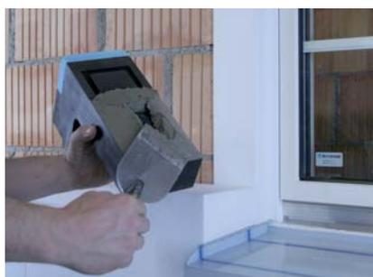
Es empfiehlt sich, den StoFix TraWik L gleichzeitig mit dem Kleben der Dämmplatten zu versetzen.
