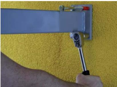
Montageobjekt mit Schraubdübeln im Mauerwerk verankern.
