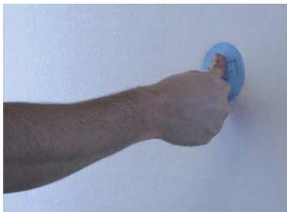
StoFix Zyrillo dämmplattenbündig in die Ausfräsung pressen. Die blaue Farbe erleichtert die Kontrolle, ob alle StoFix Zyrillo versetzt sind.
