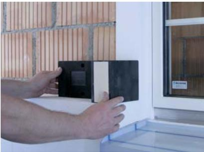
StoFix TraWik F dämmplattenbündig anpressen.
