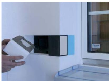
Passtück aus Dämmplattenmaterial für vorhandene Aussparung zuschneiden, Klebemörtel aufziehen und dämmplattenbündig anpressen.
