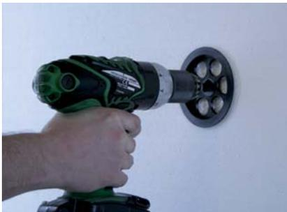
Mit Fräswerkzeug für StoFix Rondelle Ausfräsung in Dämmplatte fräsen und vom Frässtaub reinigen.
