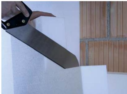
Es empfiehlt sich, die StoFix Quader Maxi gleichzeitig mit dem Kleben der Dämmplatten zu versetzen.
