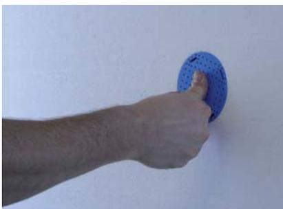
StoFix Rondelle dämmplattenbündig in die Ausfräsung pressen.
