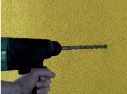
Dübelloch durch das Wärmedämmsystem bis ins Mauerwerk bohren.
