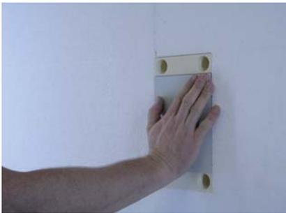
StoFix UMP-R dämmplattenbündig anpressen.
