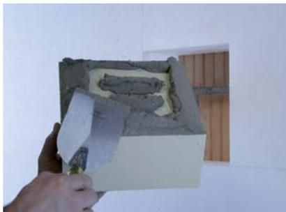
Auf die innere Klebefläche des StoFix Quader Maxi Klebemörtel aufziehen.
