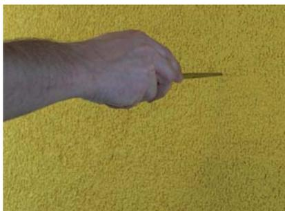
Ein Vorstechen mit einer Ahle erleichtert das Ansetzen der Schraube. Vorbohren ist nicht notwendig.
