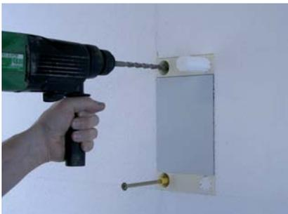
Nach dem Aushärten des Klebemörtels Schraubdübel versetzen und Bohrungen mit EPS-Stopfen schliessen. Die Eignung der mitgelieferten Schraubdübel muss für den vorliegenden Untergrund überprüft werden. Falls diese nicht geeignet sind, müssen sie auf Kosten des Bestellers ausgetauscht werden.
