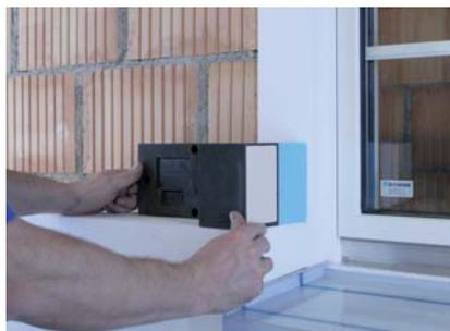
StoFix TraWik L dämmplattenbündig anpressen.
