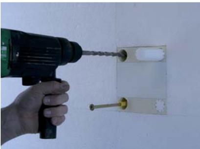
Nach dem Aushärten des Klebemörtels Schraubdübel versetzen und Bohrungen mit EPS-Stopfen schließen. Die Eignung der mitgelieferten Schraubdübel muss für den vorliegenden Untergrund überprüft werden. Falls diese nicht geeignet sind, müssen sie auf Kosten des Bestellers ausgetauscht werden.
